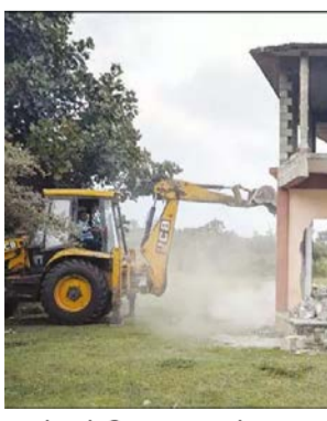
டப்பட்டு உள்ளதாக ஐகோர்ட்டில் வழக்கு தொடர்த்தார். அந்த வழக்கு விசாரணை நடைபெற்று வந்தது. இறுதியில் யானை வழித்தடத்தில் கட்டப்பட்ட விடுதி கட்டிடத்தை உடனடியாக அகற்ற வேண்டும் என ஐகோர்ட்டு உத்தரவிட்டது. இது தொடர்பாக அதிகாரிகள் ஆலோசனை நடத்தி, ஐகோர்ட்டு உத்தரவை நிறைவேற்றுவது என முடிவு செய்தனர். இந்த நிலையில் கூடலூர் வட்டார வளர்ச்சி அலுவலர் சப்பிரமணி தலைமையில் வருவாய்த்துறை, போலீசார், வனத்துறை நிர்வாக இணைத்து வாழைத் தோட்டம் பகுதியில்
